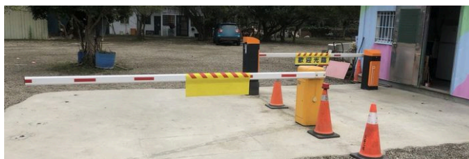
完工：出口柵欄與入口柵欄並排
