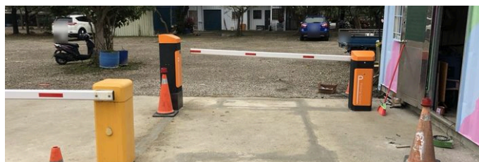
出口新設柵欄機與投幣機，地面埋設感應線圈
