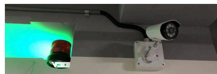
重新接管固定，接線盒封蓋
